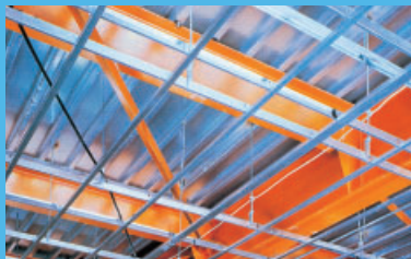
鉄製天井下地、石膏ボードほか
